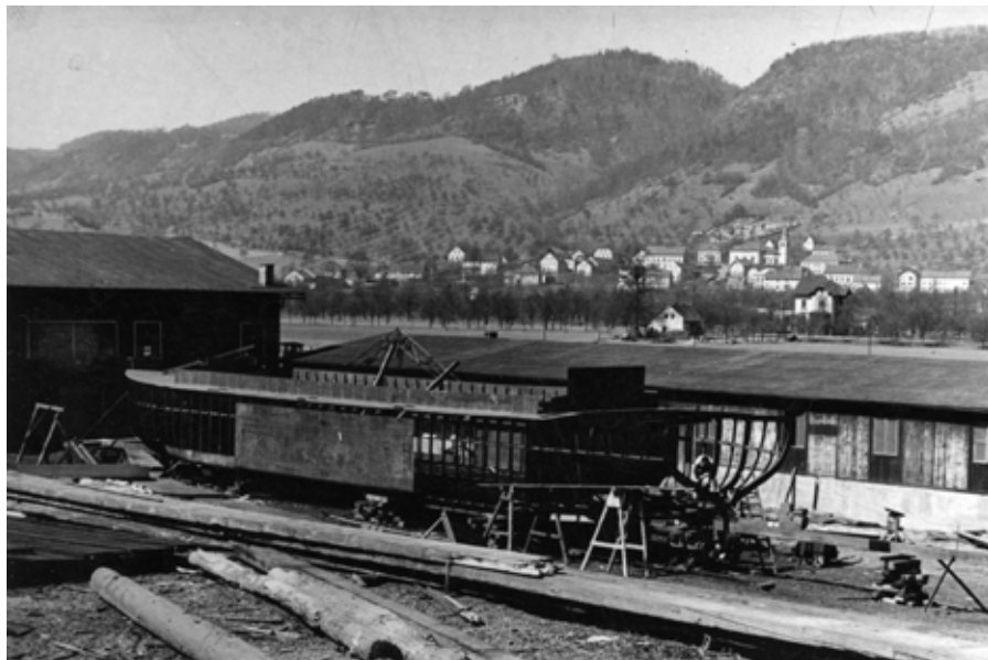
Stavba celokovové nýtované lodní konstrukce ve Valtířově ve 30. až 40. letech 20. stol. (foto sbírka Muzea města Ústí n. L.)
