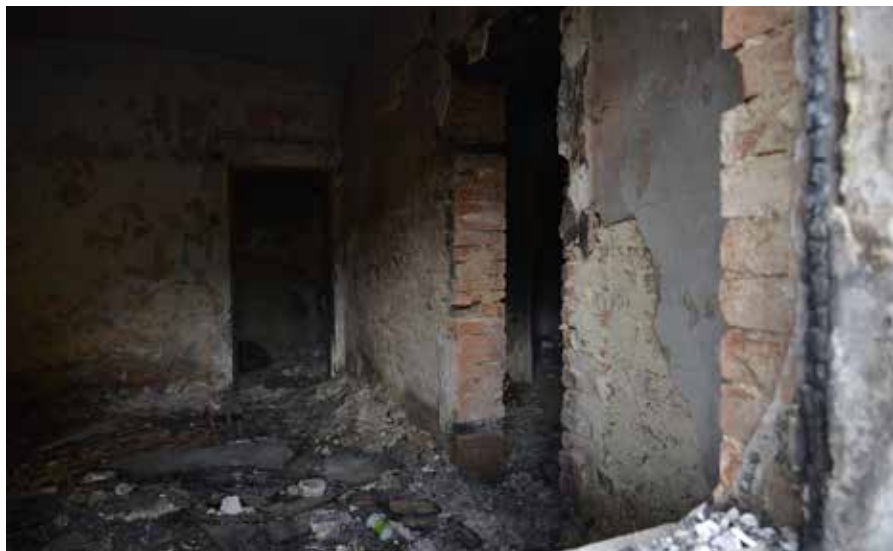
Vnitřní prostory budov, 2018 (foto J. Preclík)
