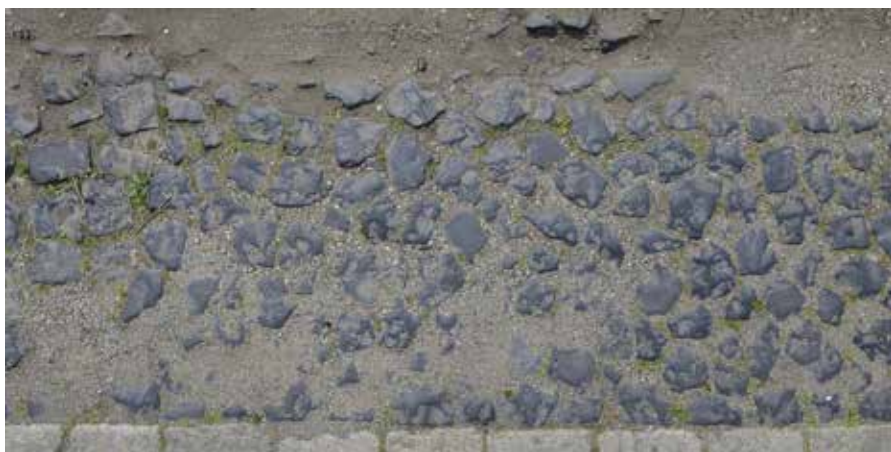
Opuštěné a zchátralé budovy Nového města a pozůstatek původní čedičové dlažby v ulici U České besedy, 2017 (foto J. Preclík)
